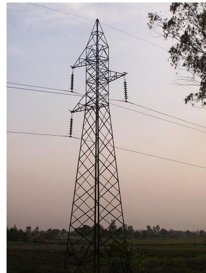
Slika 4. Dalekovod sa vodom za uzemljenje na vrhu stuba
